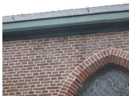
dichting lek uitzetband noordzijde
