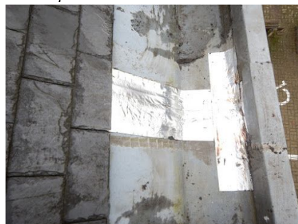
dichting lek uitzetband noordzijde
