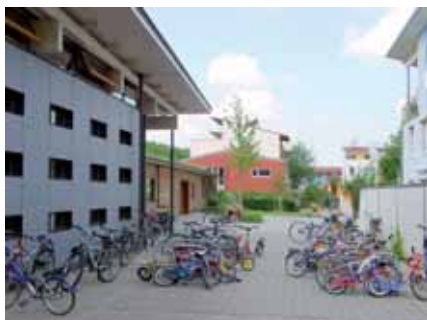
fietsenstalling Kinderdagverblijf Vauban Freiburg
